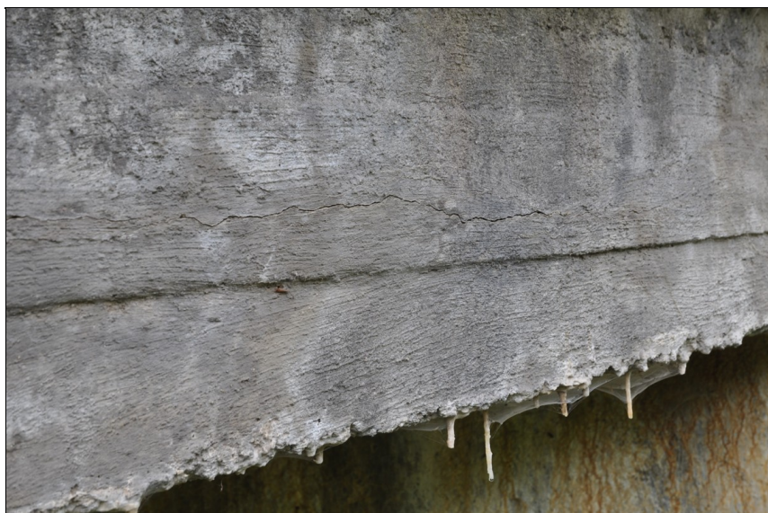
Detail trhliny na nosné konstrukci vpravo.
