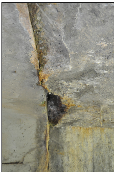
Kaverna na styku monolitické desky a příčle prefabrikovaného rámu.
