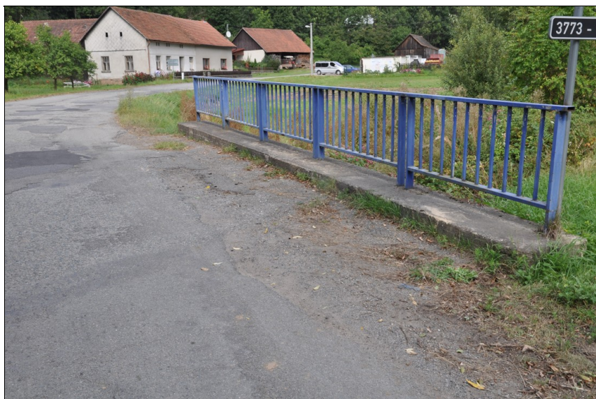
Římsa a zábradlí vpravo. Zpevnění není dotaženo až k římse.
