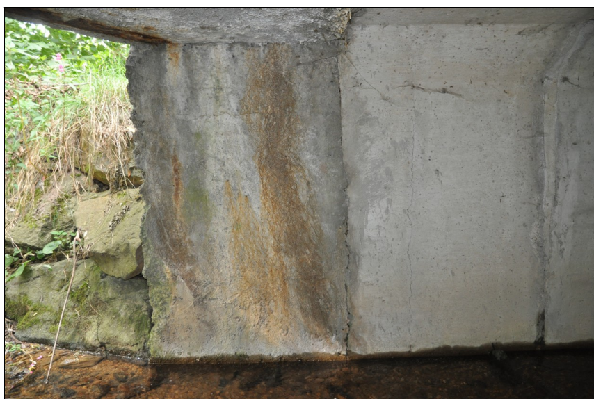
Opěra 2 s monolitickou dobetonávkou vlevo.
