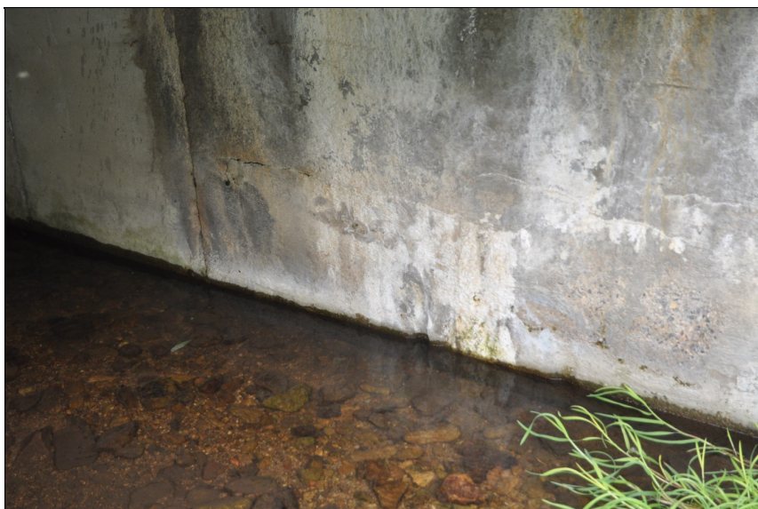
Monolitická část opěry 2 vpravo s vodorovnými zvodnělými trhlinami.
