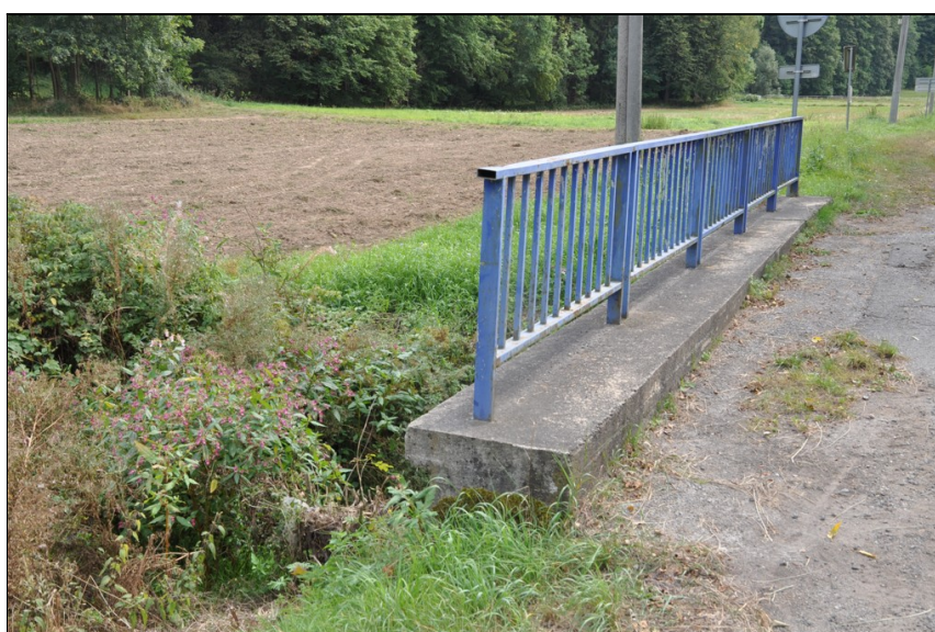
Římsa a zábradlí vpravo proti staničení.
