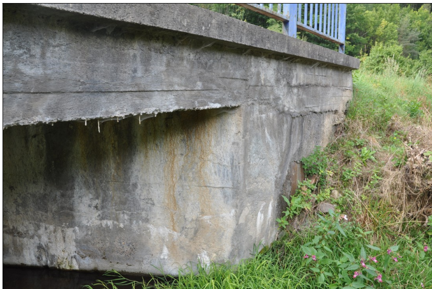
Kaverna na styku monolitické desky a příčle prefabrikovaného rámu.
