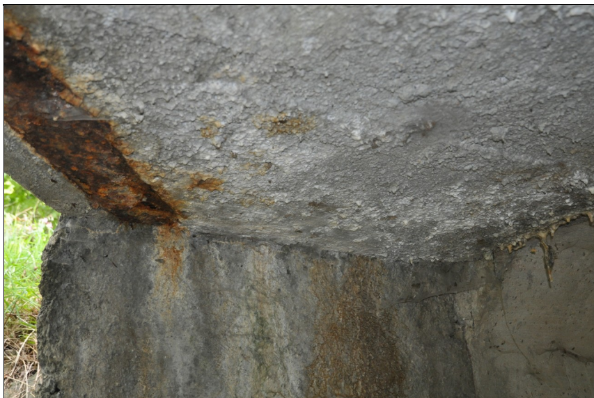
Korodující dolní příruba ocelového profilu.
