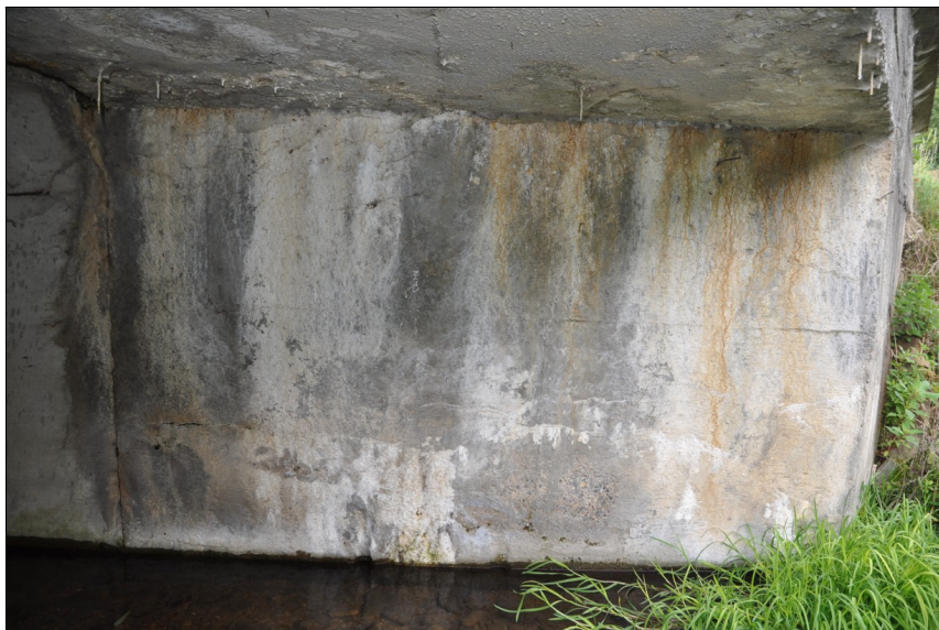
Opěra 2 s monolitickou dobetonávkou vpravo.
